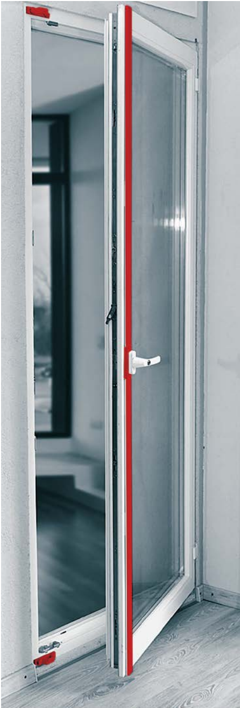
Illustrazione 10: chiusura a spagnoletta per finestra/ portafinestra.
